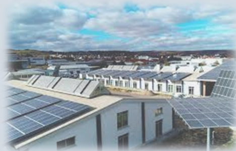
PV-Anlage und Solartracker auf dem ASS-Campus
